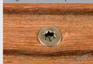
Wstępne nawiercanie + wkręt Terrassotec
